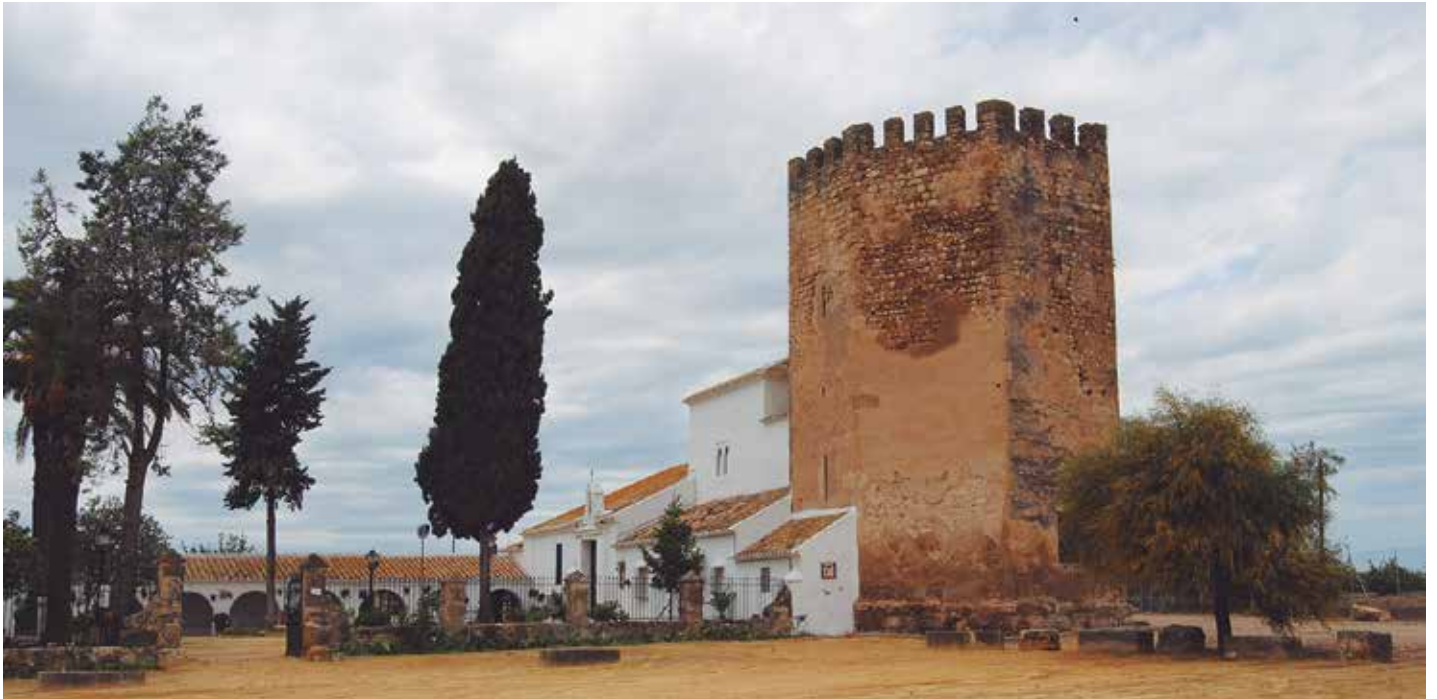
• Torre de Loreto, Espartinas. • Hacienda La Motilla, Huévar del Aljarafe. • Torre de los Guzmanes, La Algaba. • Ermita de Ntra. Sra. de Villadiego, Peñafior.
